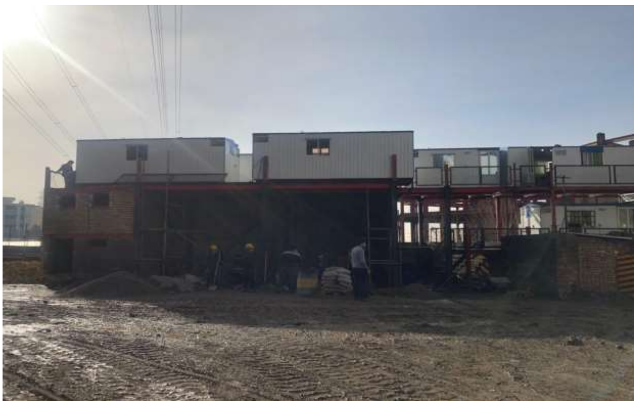
تجهیز کارگاه (مرداد ۹۹ - بهمن ۹۹)
